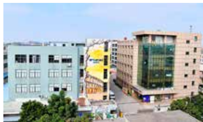
恩典公司厂区
